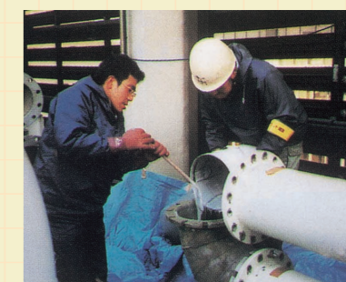
写真12 ライニング材の注入
