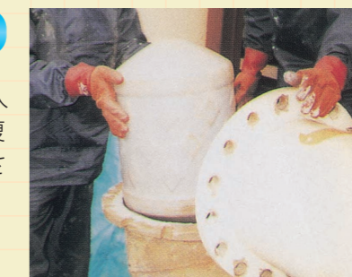
写真13 ライニングピグの挿入
