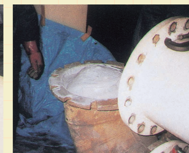
写真14 ライニングピグの回収
