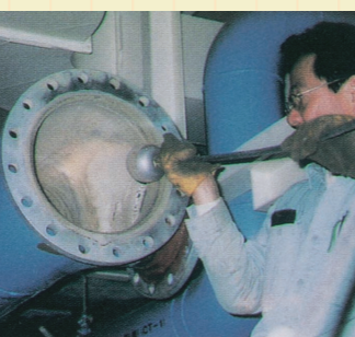
写真2 管内カメラによる内部の確認
