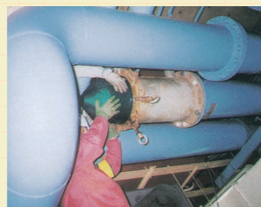
写真6 DR-スリットTypeピグによる洗浄
