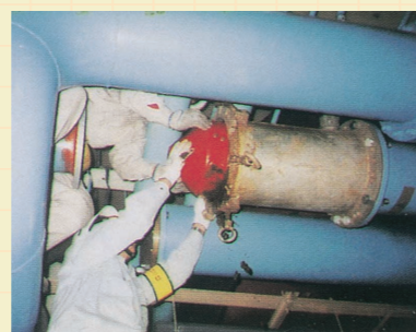
写真4 BU-Typeピグによる管内研磨
